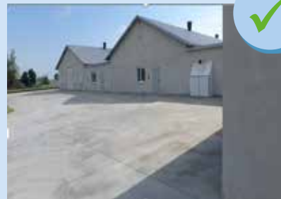
Çevreleyen beton bölge
